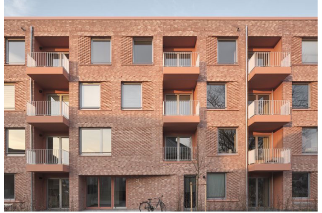
Een verticale herhaling van een set aan elementen geeft maat en schaal aan het gebouw.
